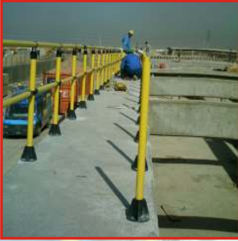
Ø40 Boru Profil Ø40 Pipe Profile
